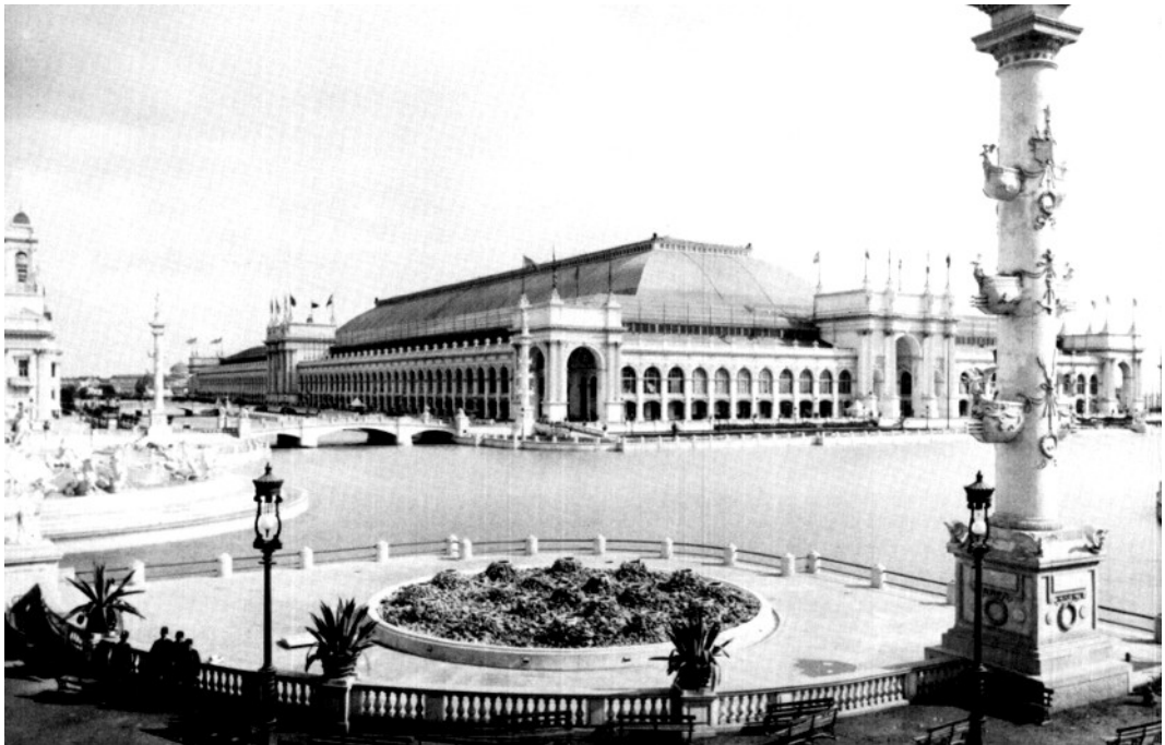
Boven: Het Manufactures and Liberal Arts Building van de World's Columbian Exposition Onder: Onder de pleisteren façades ging een modern ijzeren geraamte schuil
